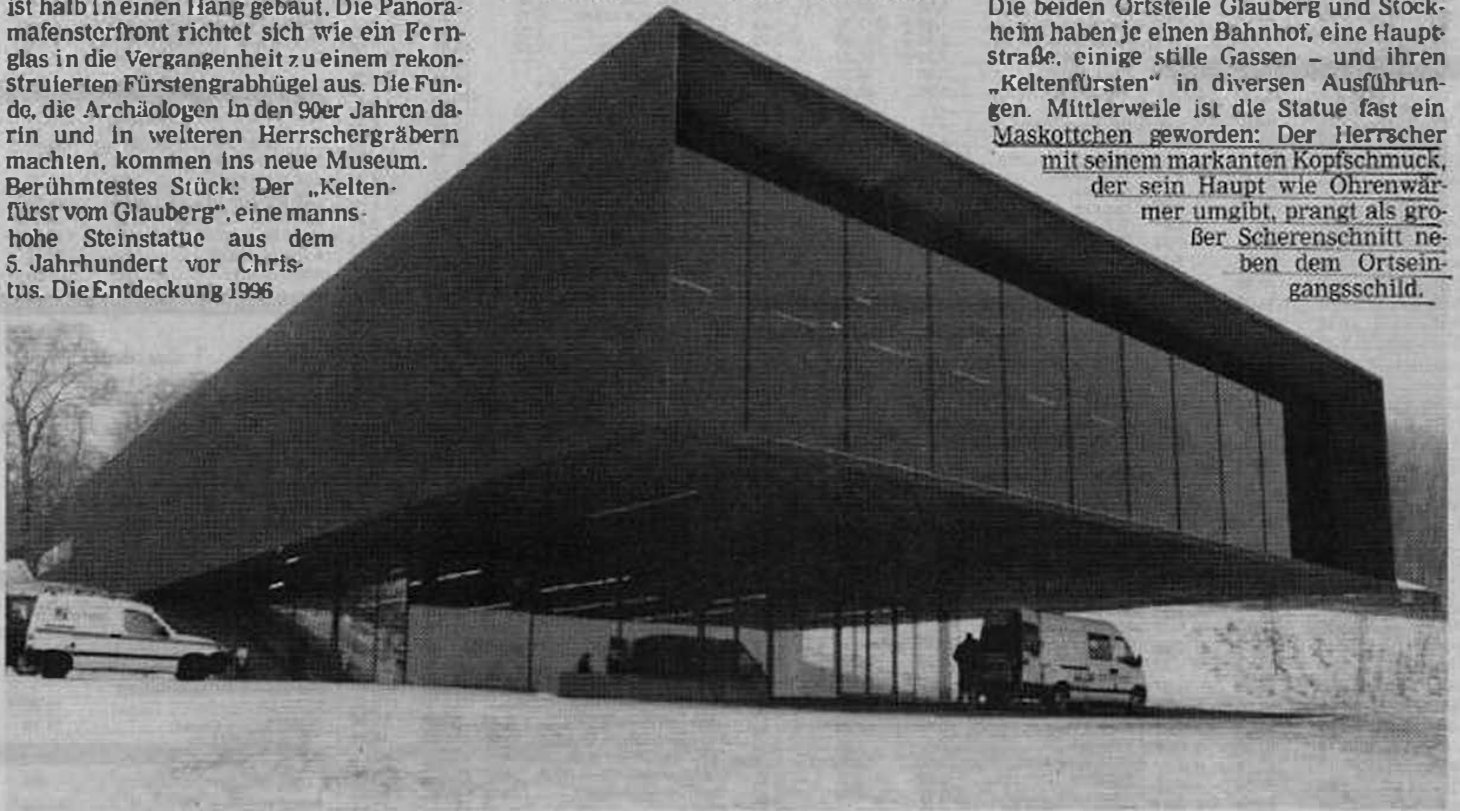
Wie eine überdimensionale Schuhschachtel mit einer Außenhaut aus angerostetem Spezialstahl und einer komplett verglasten Front wächst das neue Keltenmuseum auf dem Glauberg aus dem ehemals besiedelten Hügel heraus. Foto: dpa
