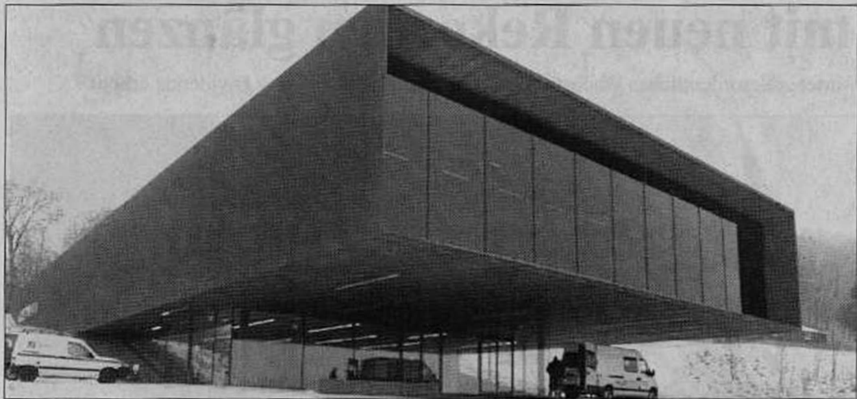
Das neue Keltenmuseum steht am Glauberg in der Wetterau kurz vor seiner Fertigstellung.
