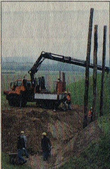
Einbau der Pfosten auf dem Glauberg. Foto: Lori
