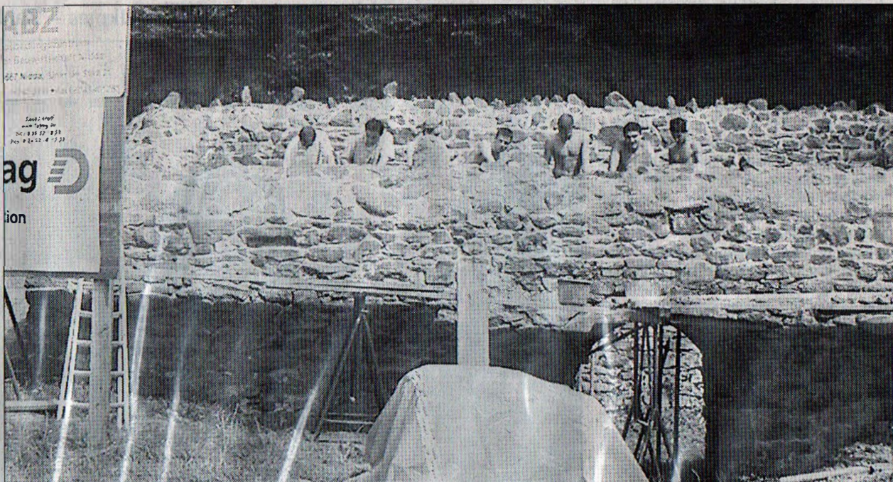
Eine sauber und exakt gearbeitete Natursteinmauer präsentieren die Lehrlinge des Ausbildungszentrums der Bauwirtschaft. Auf dem Glauberg sanierten sie die Grundmauern der einstigen staufischen Burg. Bild: Schinzel
