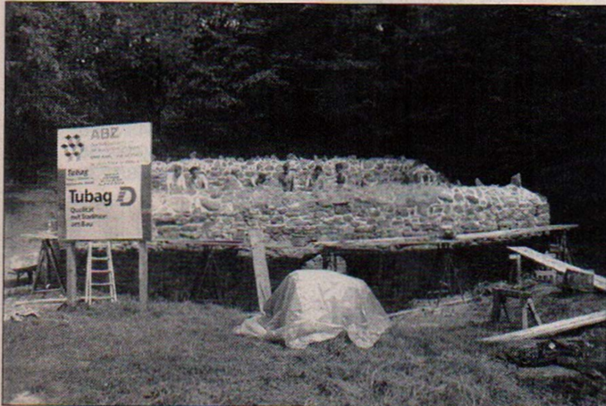
Die Lehrlinge des ABZ bei den Arbeiten an der staufischen Burgruine
